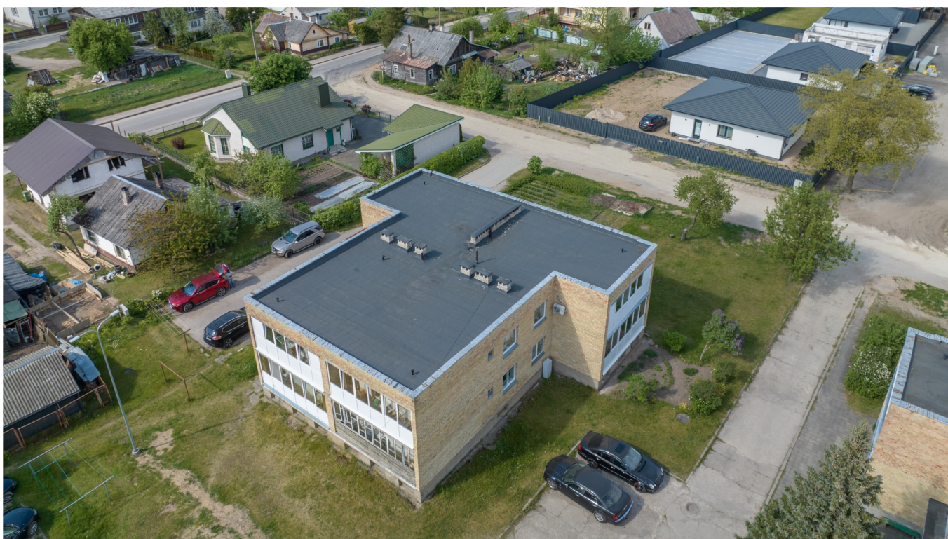
3 pav. Modernizuojamo pastato esama būklė
