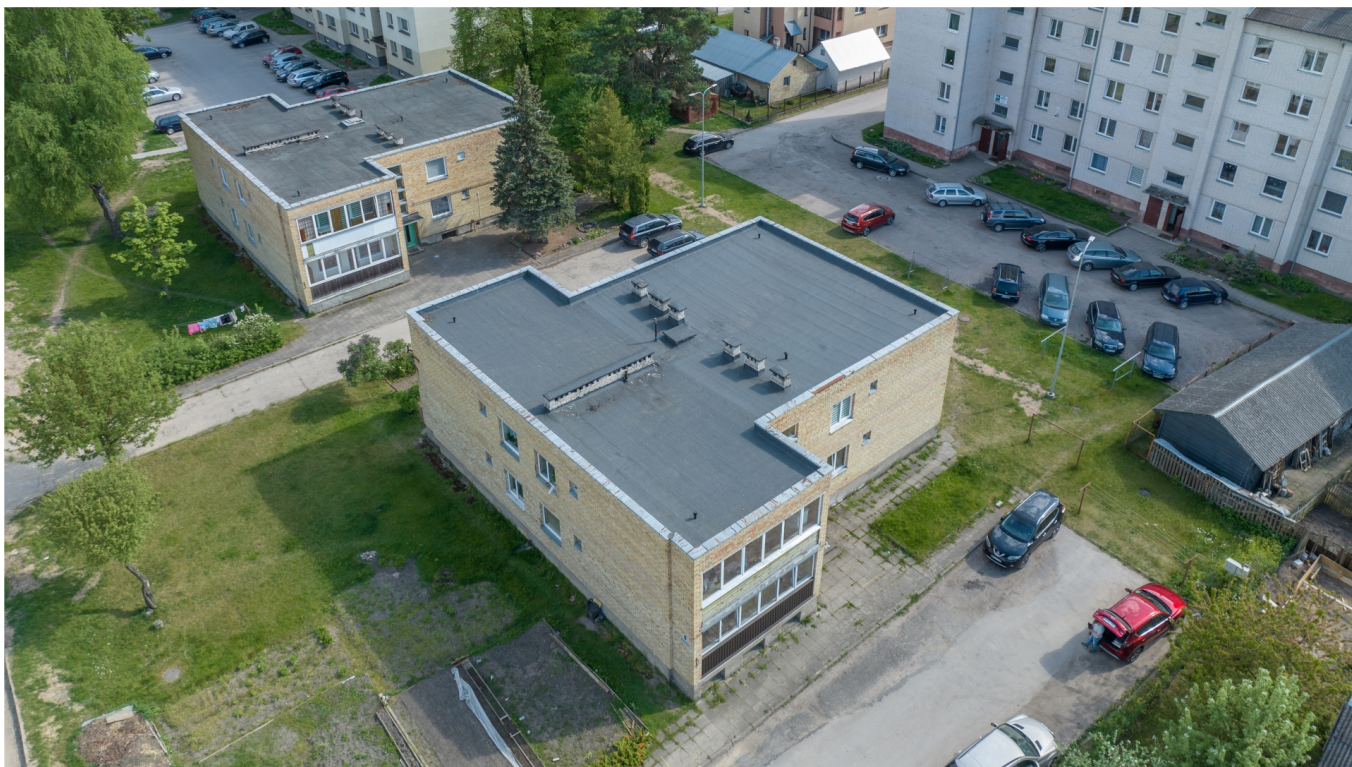
2 pav. Modernizuojamo pastato esama būklė
