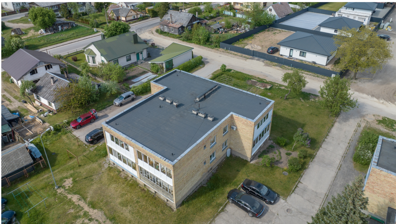
3 pav. Modernizuojamo pastato esama būklė
